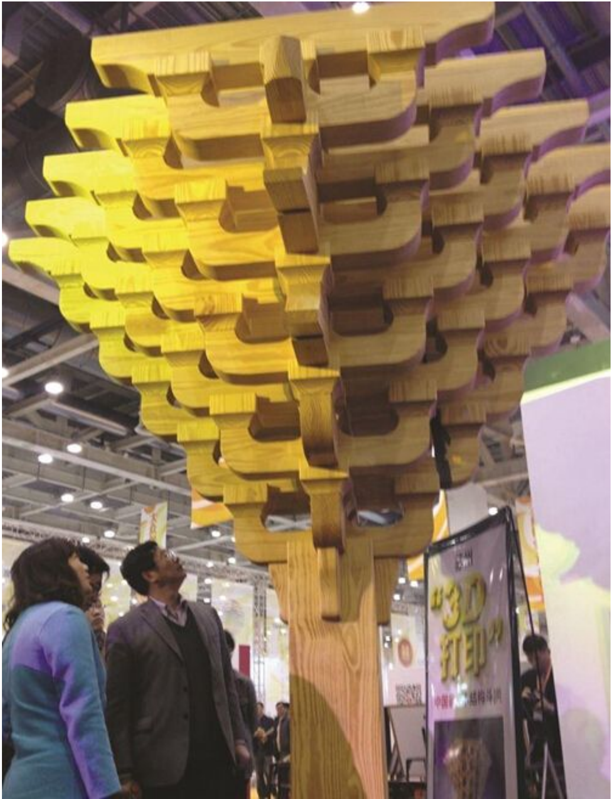
图 7 苏州创博 3D 打印斗拱结构图
