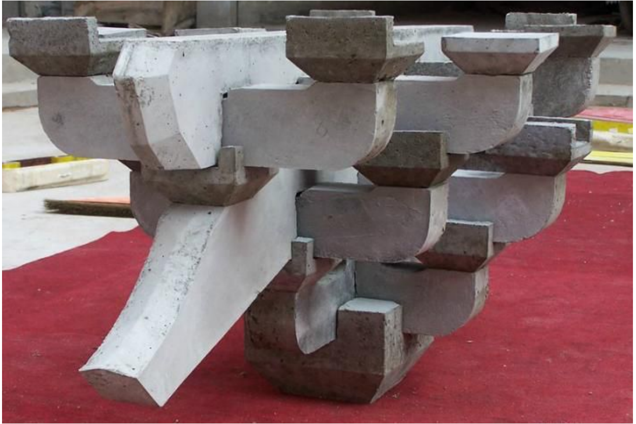
图 6 混凝土斗拱结构图
